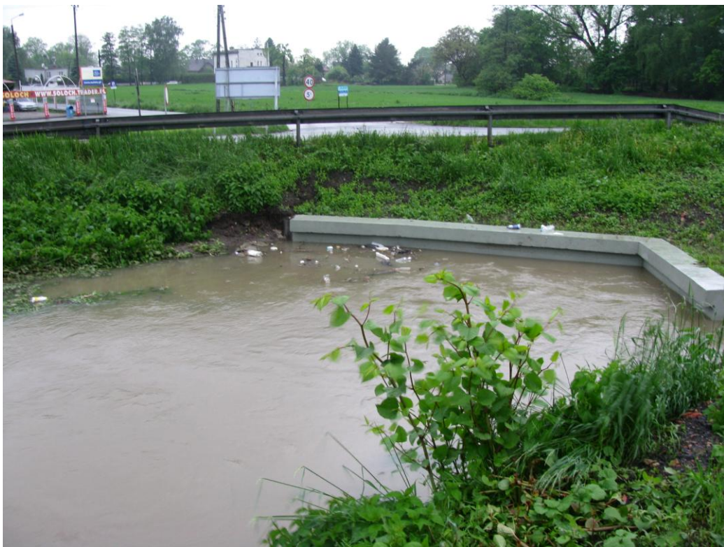
Fot. 18. Przepust pod drogą krajową nr 1
