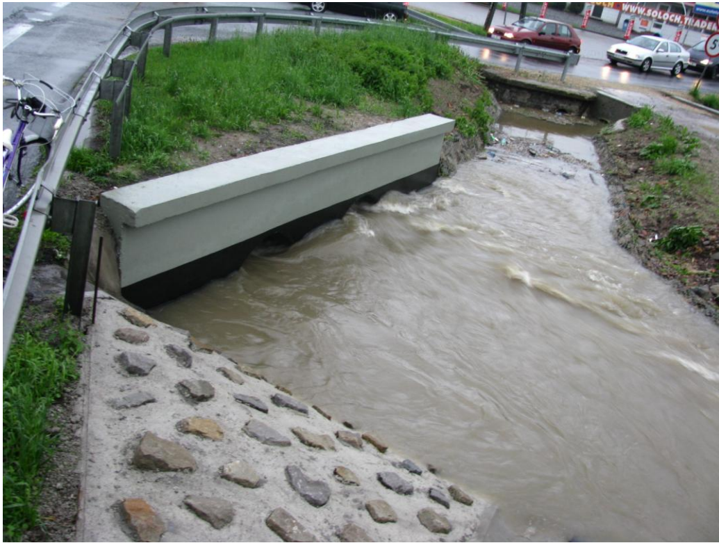
Fot. 17. Przepust pod drogą krajową nr 1
