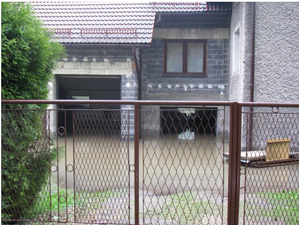
Fot. 10. Ulica Główna – zalany garaż i piwnice
