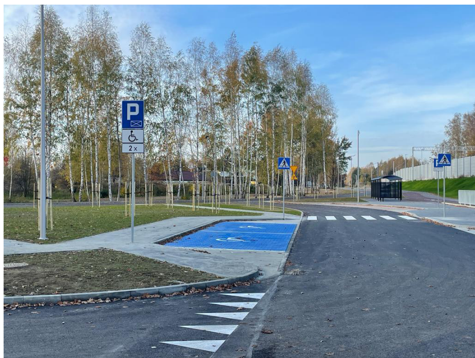
Nowe centrum przesiadkowe powstało przy ul. PCK (Fot. UG)
