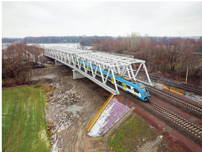
Nowy most nad Wisłą (Fot. PKP PLK)
