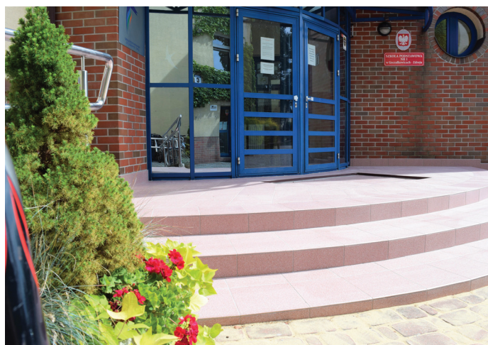
UG ▲ Wyremontowane schody przy wejściu do SP nr 1 (Fot. UG)
