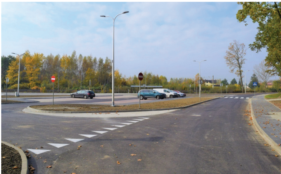
NOWE CENTRUM PRZESIADKOWE PRZY UL. PARKOWEJ
