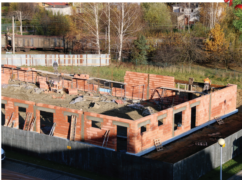
BUDOWA PRZEDSZKOLA W SĄSIEDZTWIE KOMPLEKSU SPORTOWEGO
