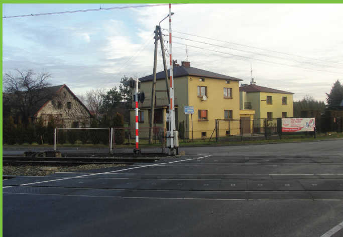
Przebudowa przejazdu kolejowego – wykonawca: PKP Linie Kolejowe SA Zakład Linii Kolejowych w Sosnowcu.
