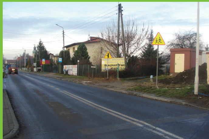
Przebudowa fragmentu ul. Szkolnej od przejazdu kolejowego, do skrzyżowania z ul. Powstańców Śląskich – wykonawca: Powiat Pszczyński.
