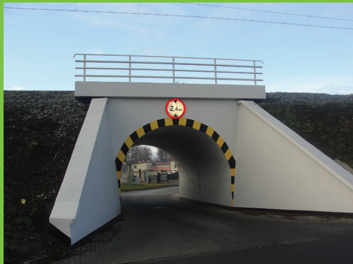
Przebudowa wiaduktu kolejowego – wykonawca: PKP Linie Kolejowe SA Zakład Linii Kolejowych w Sosnowcu.
