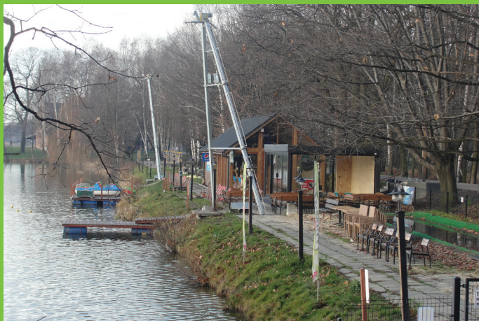
Centrum Rekreacji Wodnej WakePark nad stawem „Maciek Mały” – inwestor prywatny.
