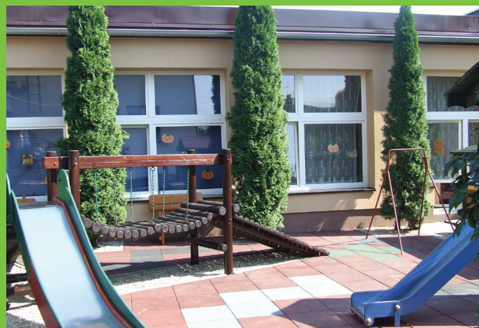
Rewitalizacja budynku Publicznego Przedszkola nr 2.
