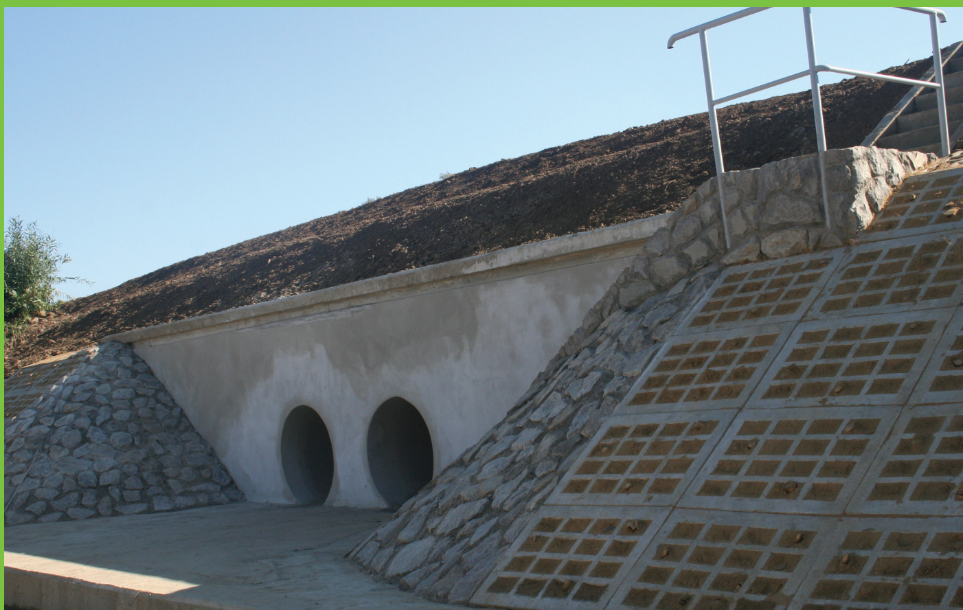
Nowa śluza wałowa na Rontoku – wykonawca: Śląski Zarząd Melioracji i Urządzeń Wodnych w Katowicach.
