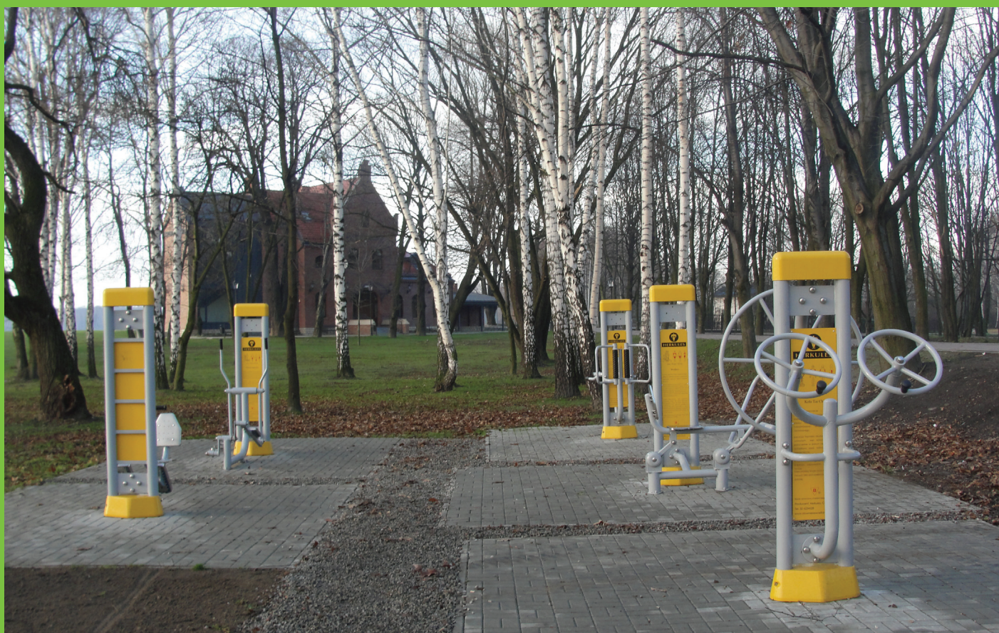
Budowa siłowni zewnętrznej w sąsiedztwie „Starego Dworca” wraz z uporządkowaniem terenu.
