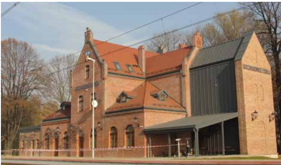
Budynek dworca kolejowego po zakończeniu II etapu remontu.
